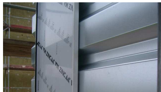
Verlegung auf Stahltrapezprofilen
