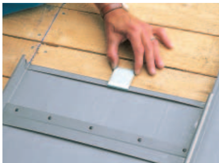
Montage der Edelstahl-Clips (Systembestandteil)
