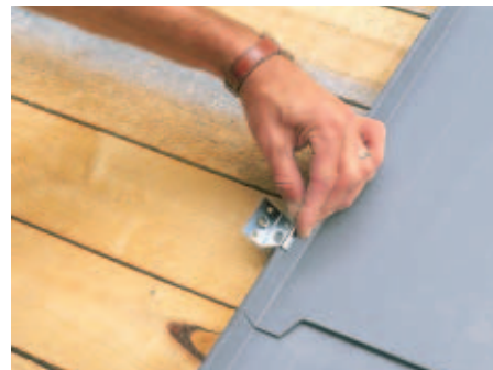
Ausrichten des Elements und Fixieren mit Plattenhaft
